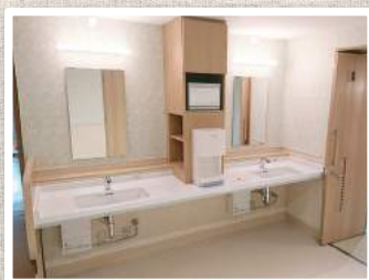
洗面台 車椅子の方も使いやすくなり、 エアータオルを設置しています。
